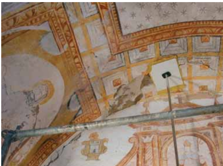
Proceso de consolidación y repellido. Foto: Jesús Puras Higuera.
