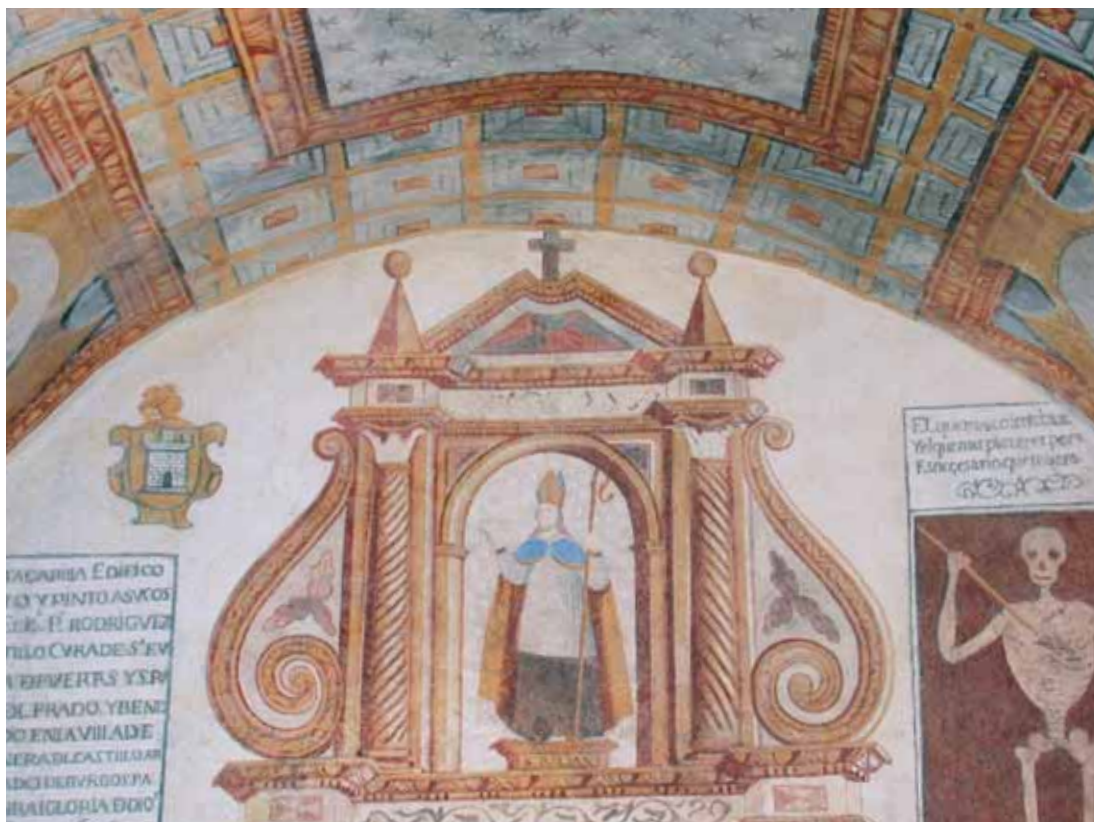
▲ Estado final de las pinturas de la cabecera tras la intervención. Foto: Jesús Puras Higuera.
