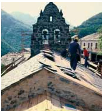
▲ Actuación en la cubierta de la nave. Fotos: Carlos Ignacio Marqués Rodríguez.
