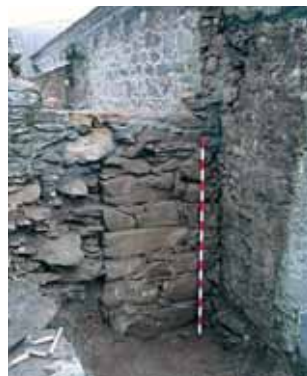
▲ Hallazgo de un nuevo contrafuerte en la cara norte. Foto: Carlos Ignacio Marqués Rodríguez.
