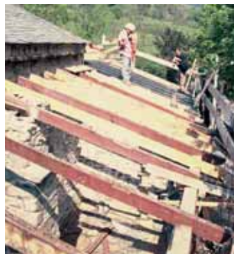
▲ Obras en la cubierta del pórtico. Foto: Carlos Ignacio Marqués Rodríguez.
