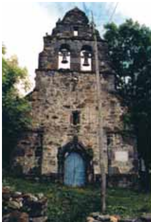
Estado previo a la intervención del imahfronte y alzado sur del templo. Fotos: ▼ Carlos Ignacio Marqués Rodríguez.
