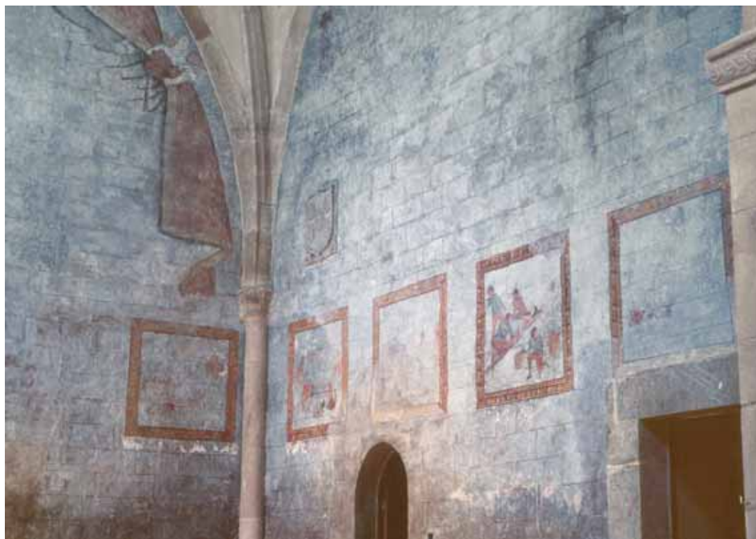
▲ Lado sur, después del tratamiento. Foto: Jesús Puras Higuera.
