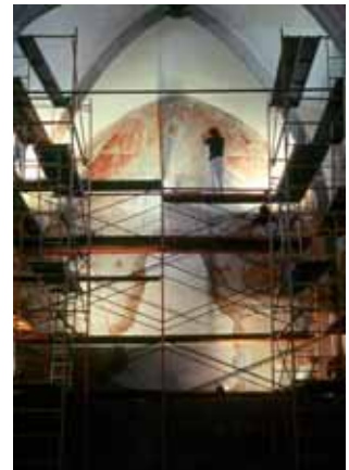
Vista general del proceso de trabajo en la cabecera. Foto: Jesús Puras Higueras.
