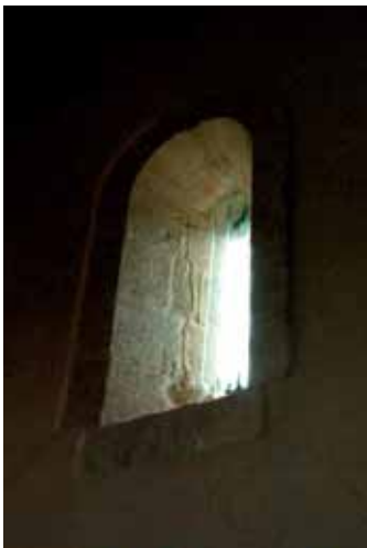
▲ Detalle de los vanos tras la restauración. Fotos: Javier Arbesú Fanjul.
