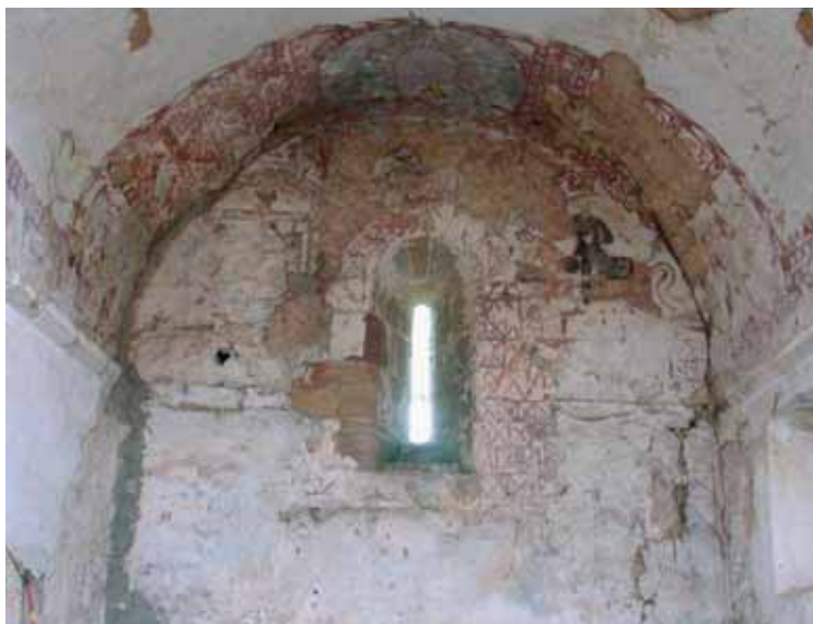
▲ Estado de la cabecera antes de la restauración. Foto: Javier Arbesú Fanjul.
