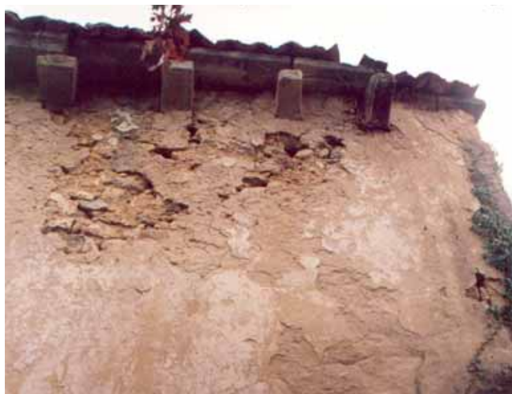
▲ Daños y grietas en la estructura de los muros. Fotos: Javier Arbesú Fanjul.
