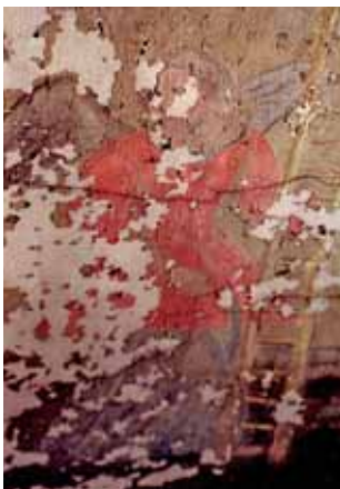
▲ Levantamiento, escamas y grietas. Foto: Natalia Díaz-Ordóñez Melgarejo.
