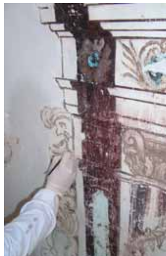
Proceso de restauración en el lateral izquierdo de la nave. Foto: MC, Conservación y Restauración.
