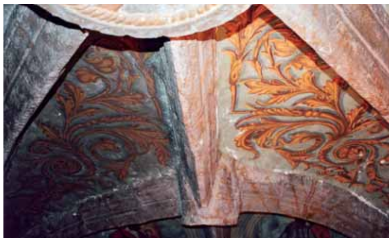
▲ Cintra limpia y estucada a la derecha y pendiente del tratamiento a la izquierda. Permite observar la luminosidad que se devuelve a la obra tras el proceso de limpieza. Foto: MC, Conservación y Restauración.
